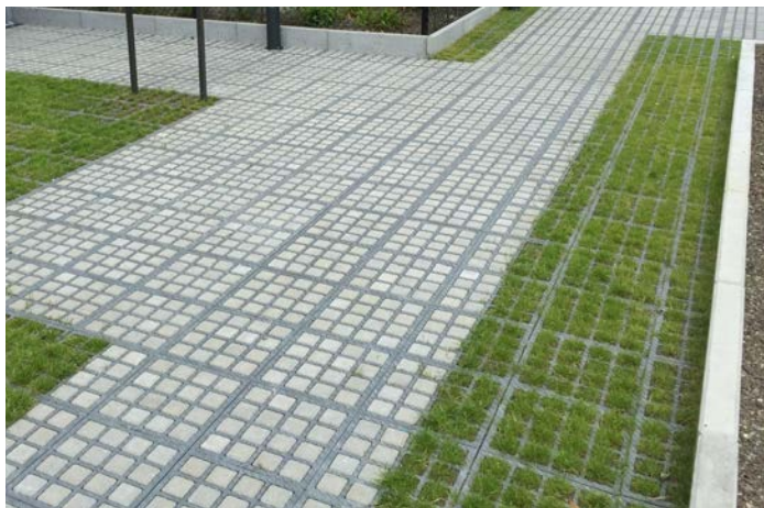
zasakovací zatravnňovací betonový rošt ( refer. př.: AS-TTE ROŠT)
