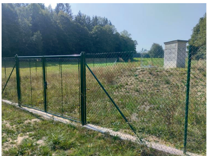
Obrázek 5 Vrt BO-1 (hloubka vrtu 62 m, průměr 254 mm)
