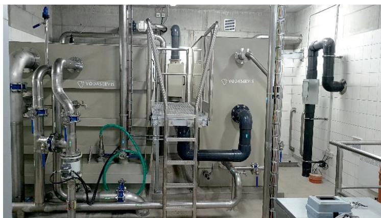
Obrázek 7 Filtr s granulovaným aktivním uhlím a provzdušňovač
