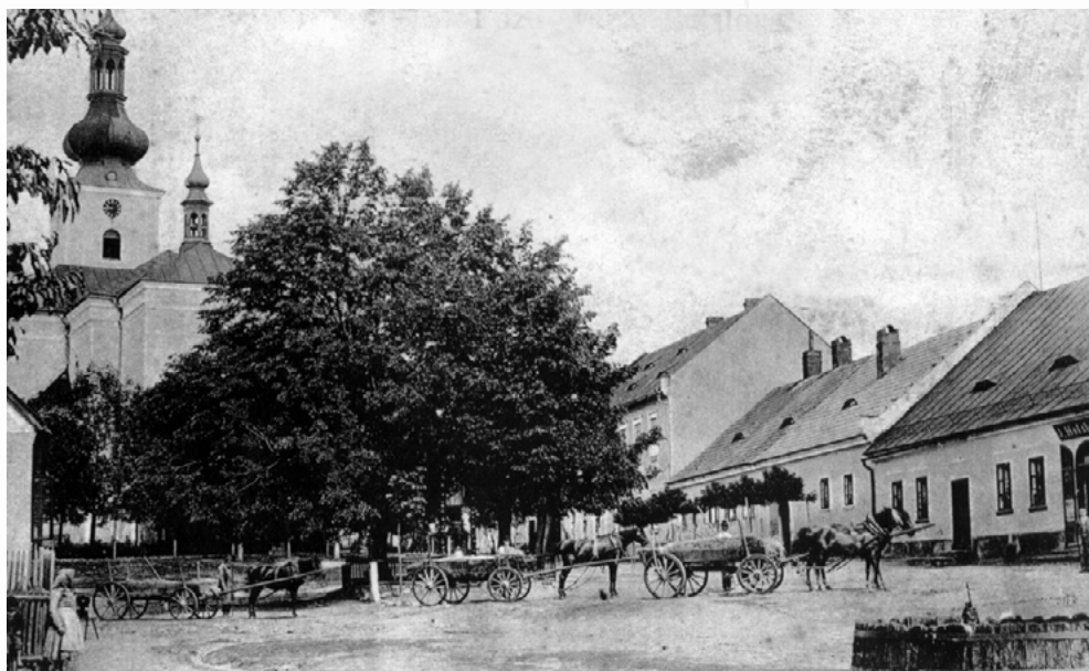
Náměstí na začátku 20. století. Kolem kostela již vznikla opěrná zeď. V pravém dolním rohu je nádrž na vodu, ze které se vyvinula dnešní chátrající kašna.
