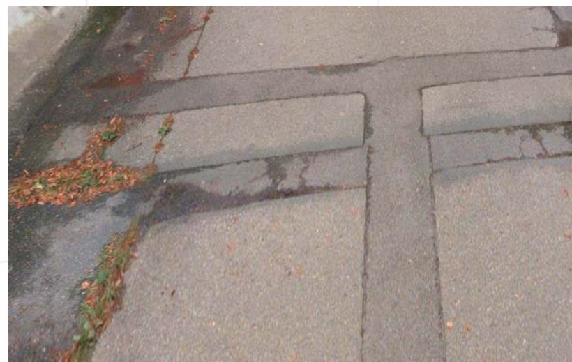
Opakované opravy asfaltového povrchu.
