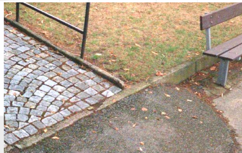
Žulová kostka směrem ke kostelu a asfaltové úpravy.
